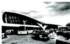
圖10 紐約甘乃迪機場候機大樓
