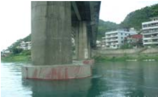
照片 2 泵送水中無收縮水泥
