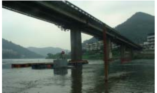
照片 3 泵送水中無收縮水泥
