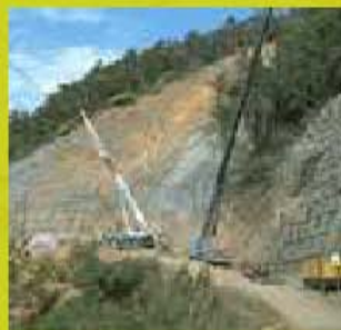
道路的开发嚴重影響山坡地
