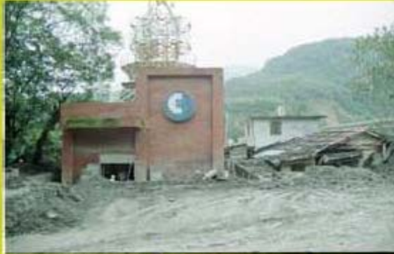
土石流容易在下游流速較緩處淤積，淹埋農地、農舍、道路與房屋建築。
