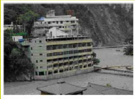
敏督利風災帶來豪雨，使大甲溪溪水暴漲，穀關溫泉區靠近河床邊之溫泉旅館遭受水及土砂侵襲
