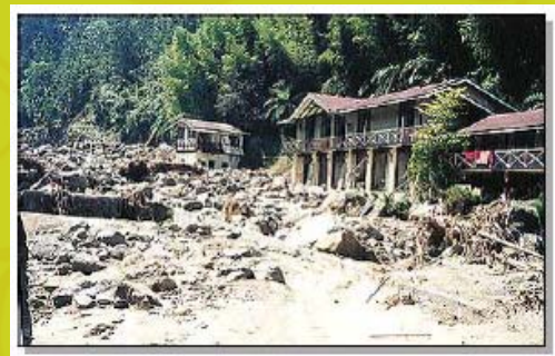
溪邊河床搭建房舍與水爭地(南投縣鹿穀鄉)
