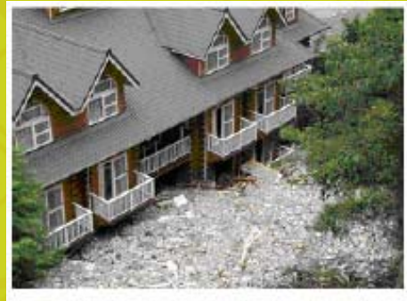
谷關溫泉區近河床之溫泉旅館受土石流侵襲，被埋約一樓高
