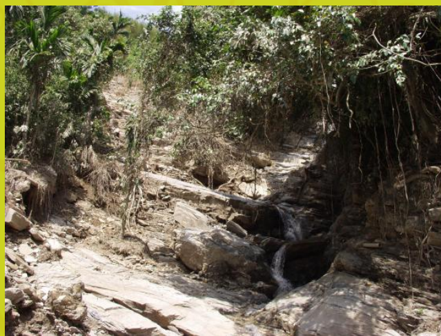
見晴村後方山坡屬於片岩構成之順向坡，岩體極為破碎，在桃芝颱風夾帶大量雨水侵蝕下，由順向坡表層岩塊滑動而後轉為土石流災害
