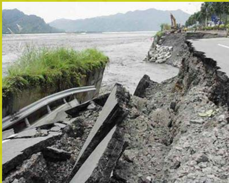
桃芝颱風重創中台灣，南投台十六線通往水裏的路基遭到洪水掏空、土石擊破護堤，道路出現超大窟窿，裂縫延伸至分隔島，險象環生
