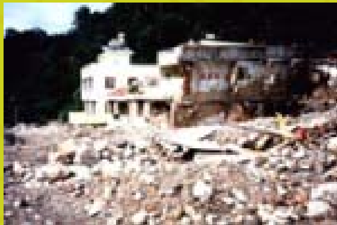
南投縣信義鄉豐丘村上游土石再度崩塌滑落
