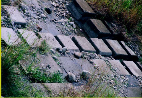
這是台中市大坑風景區的廂子坑溪，河道內的攔砂壩以方塊形消波塊堆成。
