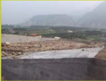
於下游設置防砂壩以容納沖刷下之土砂堆積
