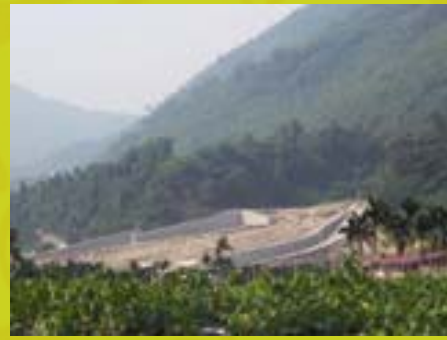
於下游設置防砂壩以容納沖刷下之土砂堆積
