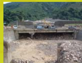
於穀口處設置沉砂池使土石流能在此處作一緩衝安全沉置
