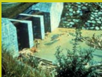
於河床上構築防砂壩或連續式潛壩以減低河床坡度降低水流流速
