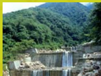
於河床上構築防砂壩或連續式潛壩以減低河床坡度降低水流流速
