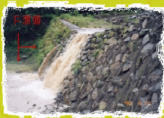
砌石壩近照圖
