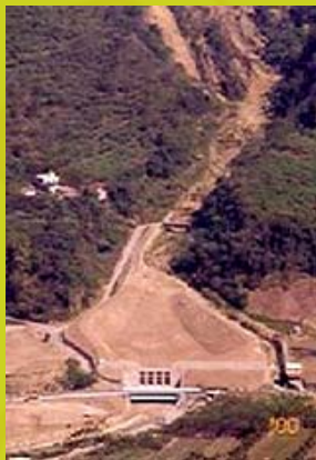
於穀口處設置沉砂池使土石流能在此處作一緩衝安全沉置
