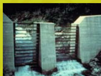
設置梳子壩或鋼管樁壩阻絕大粒徑塊石並使水與土分離
