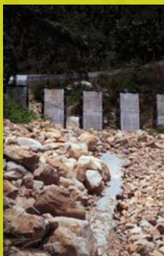
設置梳子壩或鋼管樁壩阻絕大粒徑塊石並使水與土分離
