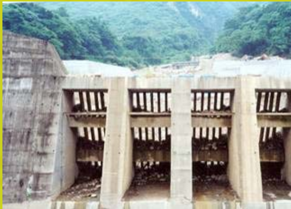
防砂壩有效阻絕土石粒料，防止土石沖刷至下游處堆積。
