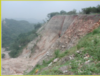
崩塌地鋪網噴植前
