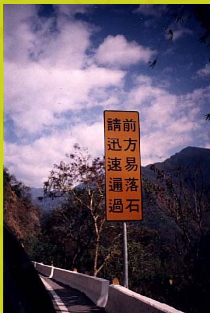
設置於道路旁之長方形黃色危險警示標誌
