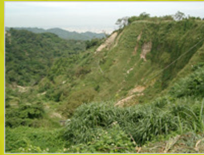
崩塌地鋪網噴植後
