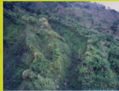
航空植生施工後
